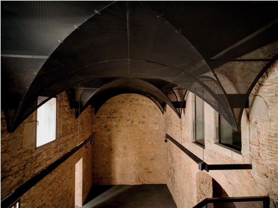
FIGURA 13. La volta de ferro a la nau central de l'Hospital de Sant Sever. Arquitectura: Garcés – de Seta – Bonet arquitectes / Fotografia: Ciro Frank Schiappa Photography.
